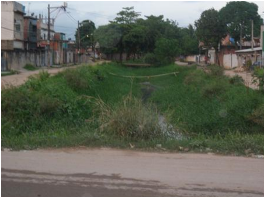
Figura 7: Início do Canal do Ipê, que deságua no Rio Iguaçú. Na imagem, é possível perceber a falta de infraestrutura no Município de Belfor Roxo (Ribeiro, 2012).
