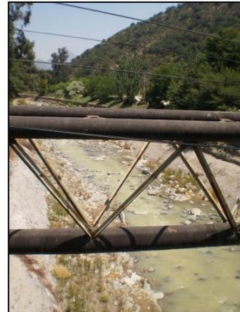
Figura 7 Erosión regresiva y canalización en el río Mapocho
