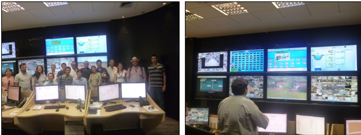
Figuras 24 (a, b)- Foto de grupo y monitores de control de la sala donde se monitoriza el plan director de drenaje
