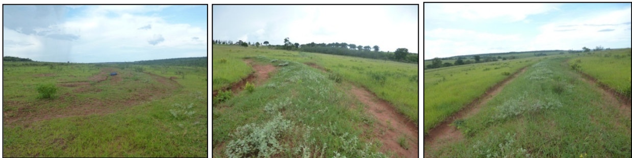
Figuras 25 (a, b, c) – Técnicas de control de erosión y pérdida de tierras (pequeñas depresiones artificiales longitudinales recogen el suelo erosionado)
