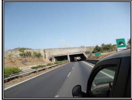
Derecha: la “fiumara” pasa por encima de la carretera en un cauce artificial!
