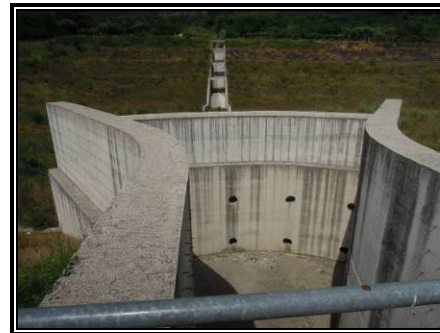
Parte alta del río Sarno. Estanque de retención de debrís flows
