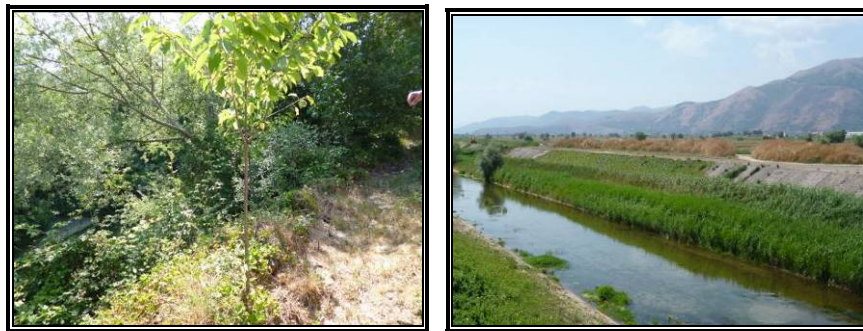
Obra de protección de orilla con Bioingeniería en el río Tanagro
