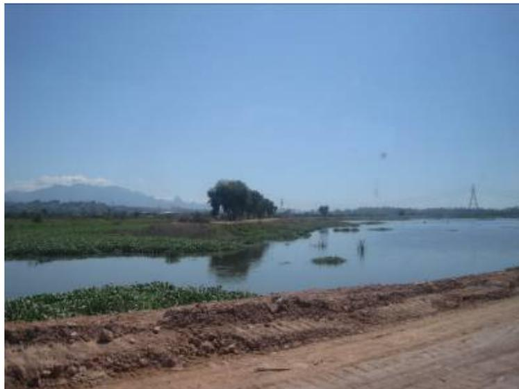
**Figura 9: Pôlder do Pilar – Observa-se que parte do dique antigo foi retirada para aumentar a área de alagamento, após reposicionamento de um novo dique.**
