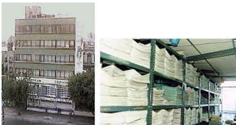
Edificaciones con sobre peso
