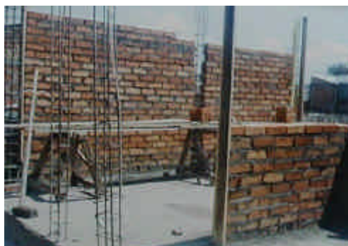
Mampostería confinada (con columnetas)
