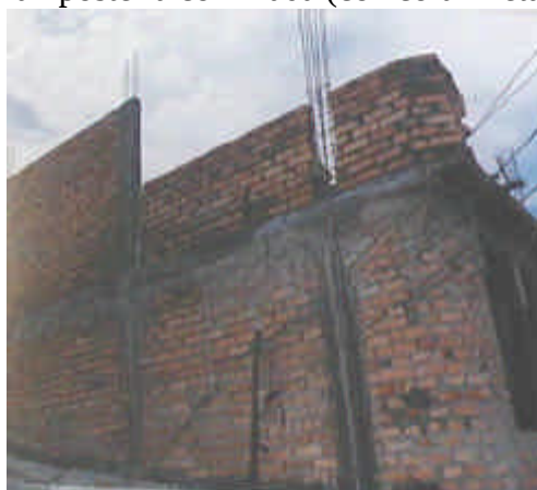
Mampostería confinada (con columnetas)
