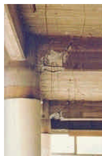
Vigas fundidas en sitio
