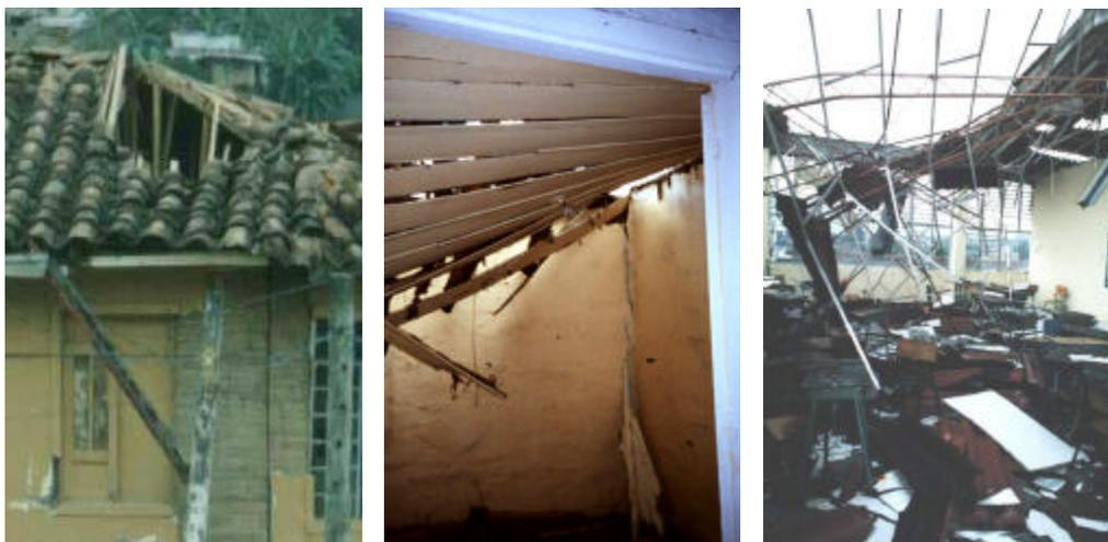
Fotografías 3-26. Daños en el sistema de cubierta
