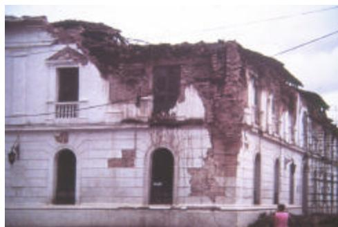
**Fotografías 3-15. Daños severos en muros de tapia**
