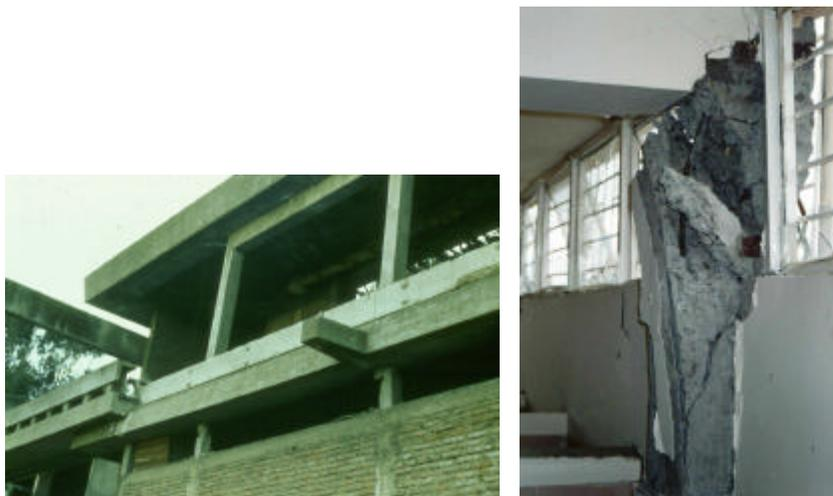
**Fotografía 3-35. Falla por efecto de columna corta**
