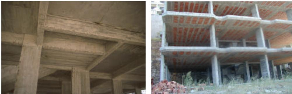
**Fotografías 3-34. Fallas en la configuración estructural**
