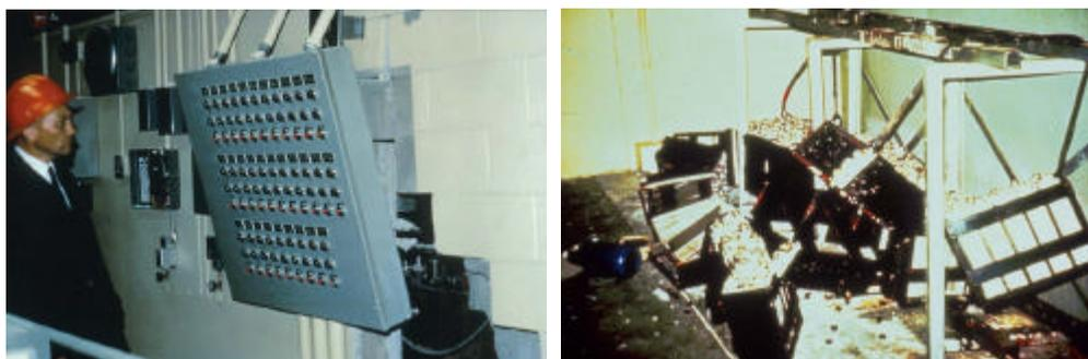
Fotografía 3-30. Daños en instalaciones y subestaciones eléctricas
