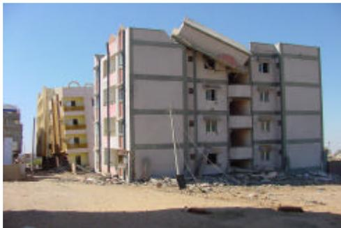
Fotografía 3-28. Daño severo en tanque elevado
