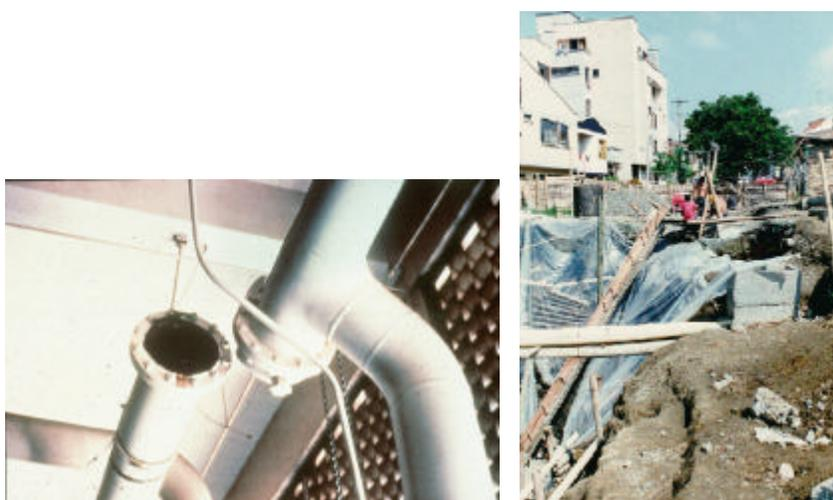
Fotografía 3-31. Daños severos en instalaciones de acueducto y alcantarillado
