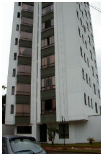
Fotografía 3-1. Edificación construida en pórticos de concreto reforzado
