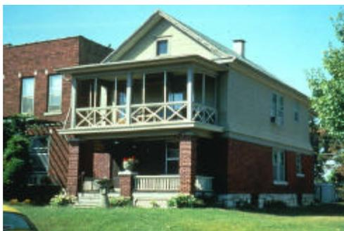
**Fotografía 3-6. Edificación construida en mampostería y madera**
