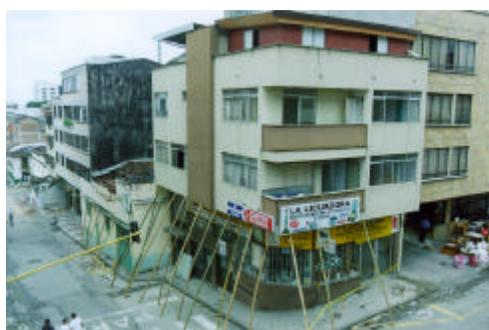
**Fotografías 3-9. Inclinación de la edificación o de un entropeso**
