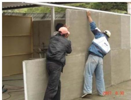
Placas en concreto para casas prefabricadas
