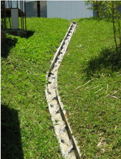
Fotografía 5. Canal de rápidas con tapa CPD
