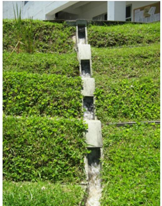
Fotografía 6. Canal de rápidas con tapa y columpio CRTC
