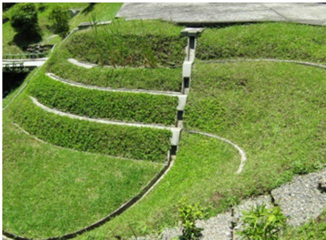
Fotografía 2. Acequias a media ladera, terraceo, canal de rápidas con tapa y columpio CRTC
