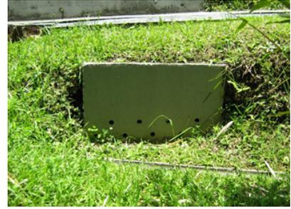
Fotografía 12. Muro en concreto ciclópeo
