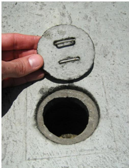
Fotografía 7. Cámara de inspección del alcantarillado
