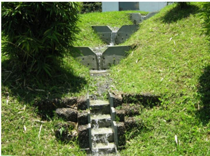
Fotografía 3. Diques en concreto y diques en gaviones
