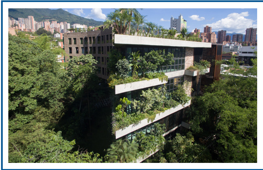
Figura 11. Ejemplo de edificaciones bioclimáticas; en la foto edificio Matorral en Medellín, Colombia. Fuente: Zambrano Nájera, 2020
