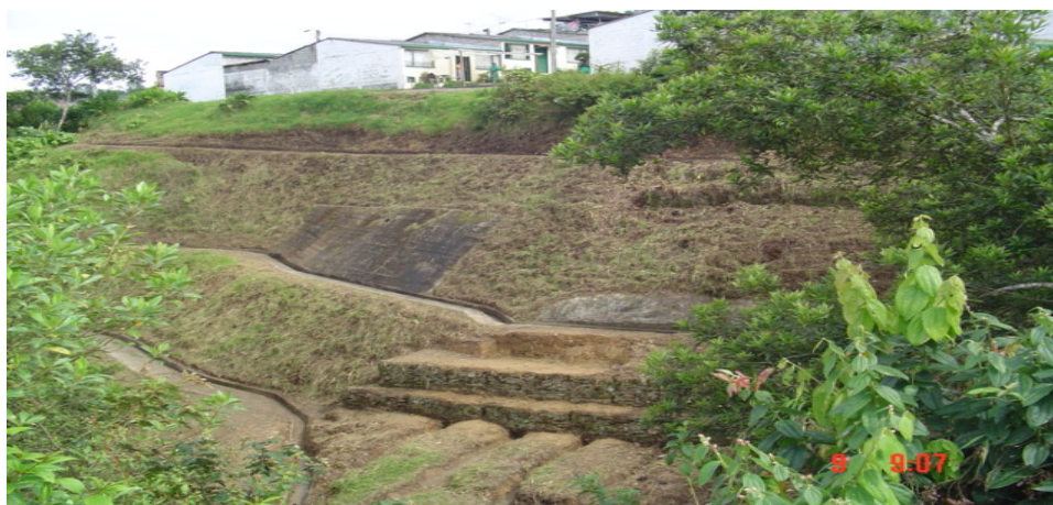
Foto N° 10. Estado de la misma ladera después de la intervención de las guardianas
